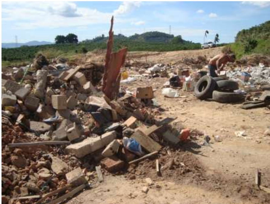
Foto 23: Identificação de outros tipos de resíduos, onde deveriam haver apenas RCC
