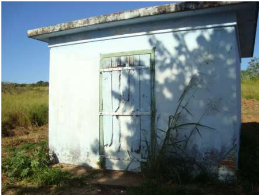
Foto 21: Área de armazenamento dos resíduos de serviço de saúde
