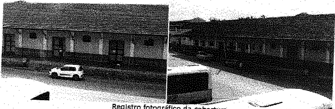
Registro fotográfico da cobertura.
