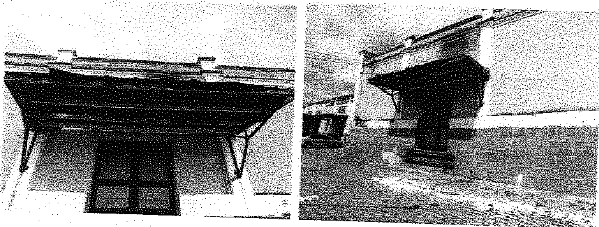
Cobertura em zinco nos acessos à Estação.
