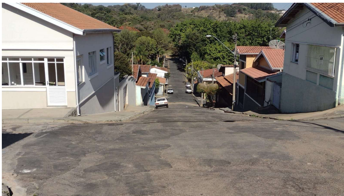
F 11 (24/Ago/21): Vista da Rua Cotinha Boreli, T-4, esquina com a Rua Ricardo Francisco de Paula, na Vila Palmeiras. Visada sentido Rua João Pinto Ramalho.
