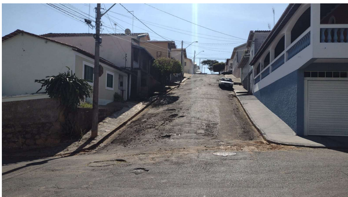
F 12 (24/Ago/21): Vista da Rua Cotinha Boreli, T-4, esquina com a Rua João Pinto Ramalho, na Vila Palmeiras. Visada sentido Rua Ricardo Francisco de Paula.
