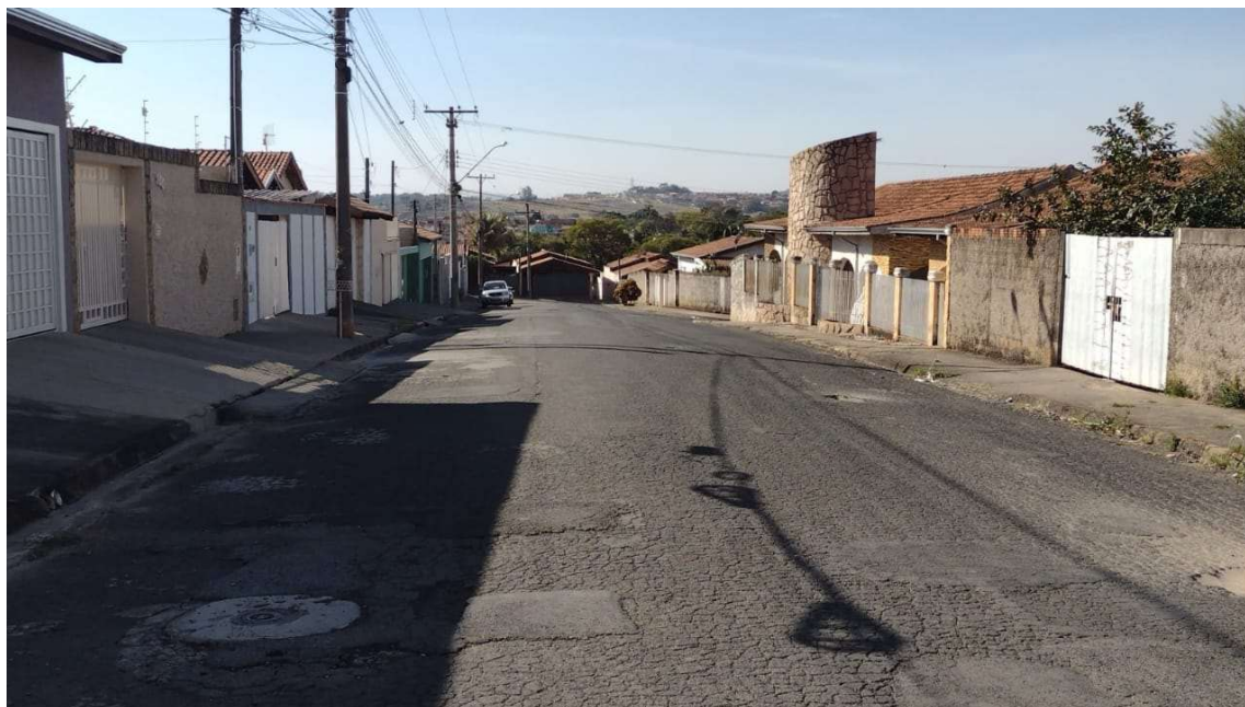
F 05 (24/Ago/21): Vista da Rua Parrile Adonis Cipolli, T-2, entre a Rua Wálter Vuolo e a Rua Adalberto Felipe Vuolo, no Jardim Varam. Altura do nº 100, visada sentido Rua Adalberto Felipe Vuolo.
