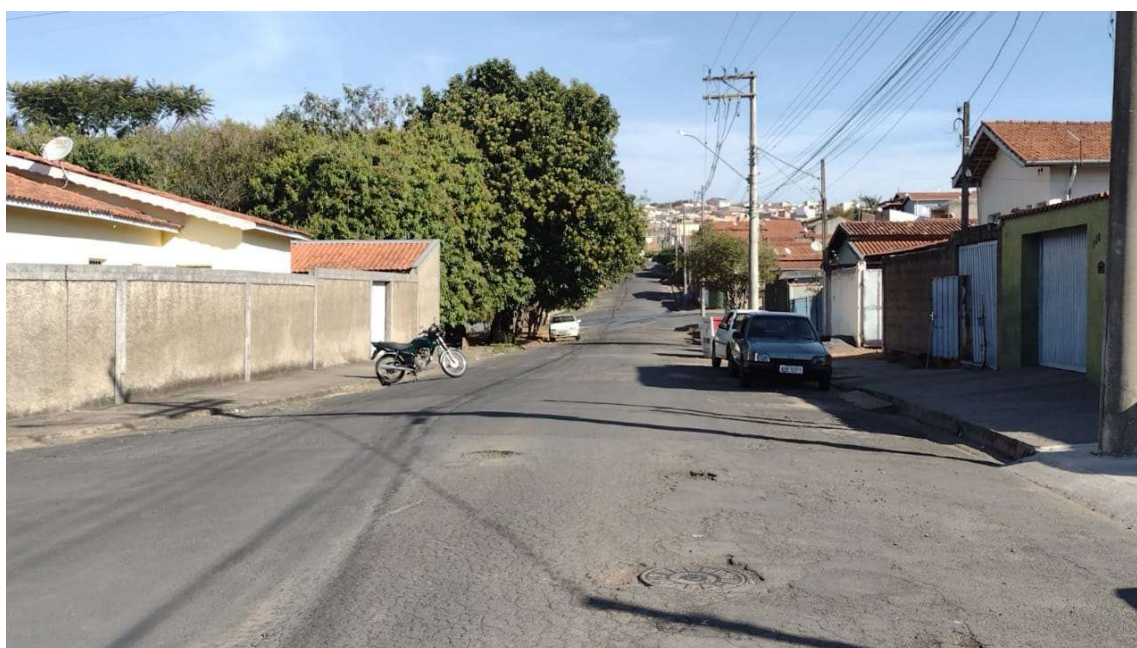
F 04 (24/Ago/21): Vista da Rua Parrile Adonis Cipolli, T-2, entre a Rua Wálter Felipe Vuolo e a Rua Emília Vuolo, no Jardim Varam. Altura do nº 140, visada sentido Rua Emília Vuolo
