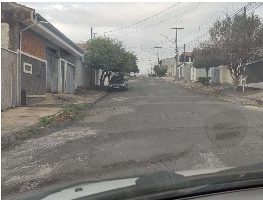
F 07 (17/Mai/21): Vista da Rua Alberto Baraldi, T-2, entre a Rua Antonio Ramponi e a Rua Emília Vuolo, no Jardim Varam. Altura do nº 215, visada sentido Rua Antonio Ramponi.
