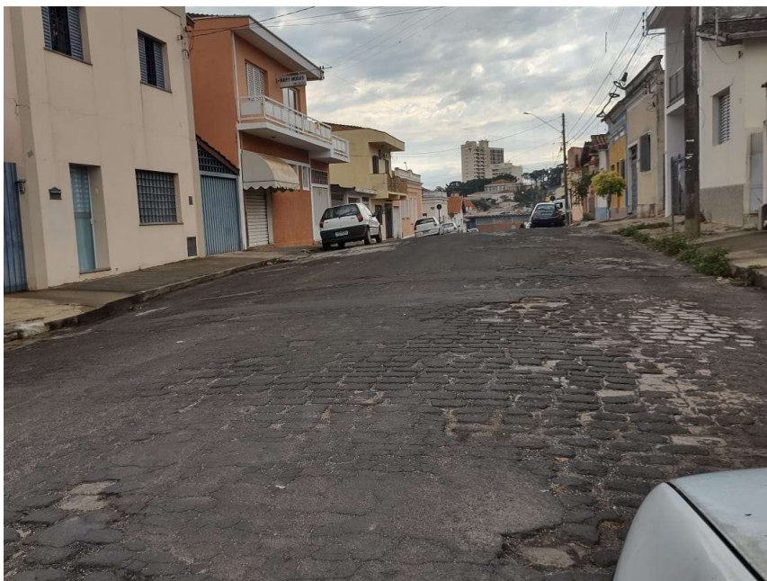
F 17 (17/Mai/21): Vista da Rua Pinheiro Chagas, T-5.1, entre a Rua Dr. João Mendes e a Rua Cel. Joaquim Leite, no Centro. Altura do nº 100, visada sentido Rua Cel. Joaquim Leite.
