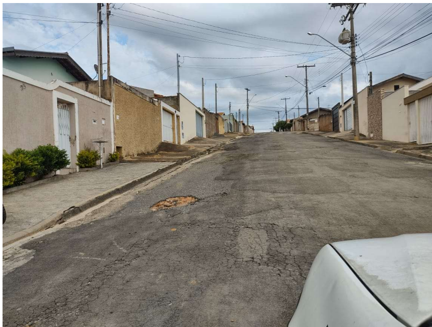
F 09 (17/Mai/21): Vista da Rua Alberto Baraldi, T-2, entre a Rua Emília Vuolo e a Rua João Batista Sertório, no Jardim Varam. Altura do nº 50, visada sentido Rua Emília Vuolo.
