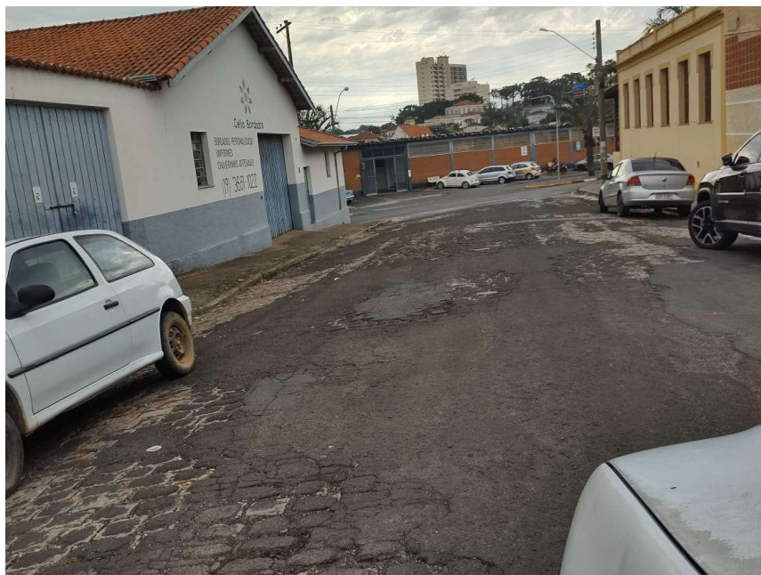
F 19 (17/Mai/21): Vista da Rua Pinheiro Chagas, T-5.2, entre a Rua Cel. Joaquim Leite e a Av. Quirino dos Santos, no Centro. Altura do nº 22, visada sentido Av. Quirino dos Santos.
