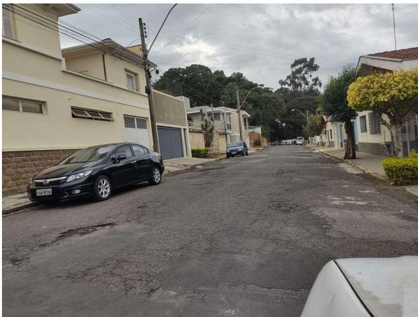
F 21 (17/Mai/21): Vista da Rua Cap. Carlos Teixeira, T-6.4, entre a Rua Hadock Lobo e a Rua Canto Sobrinho, no Centro. Altura do nº 166, visada sentido Rua Canto Sobrinho.
