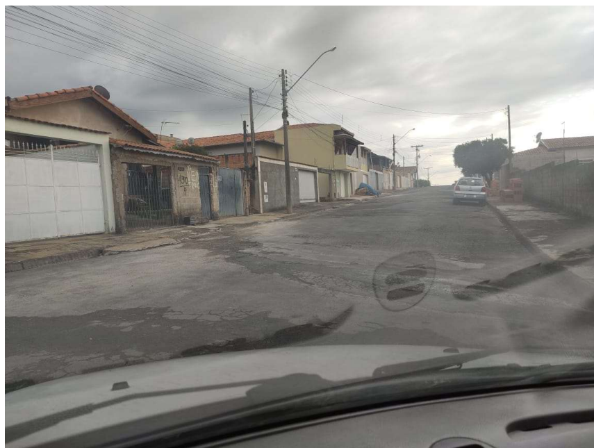
F 04 (17/Mai/21): Vista da Rua Luiz Pizzi, T-1, entre a Rua Antonio Ramponi e a Rua Emília Vuolo, no Jardim Varam. Altura do nº 410, visada sentido Rua Emília Vuolo.
