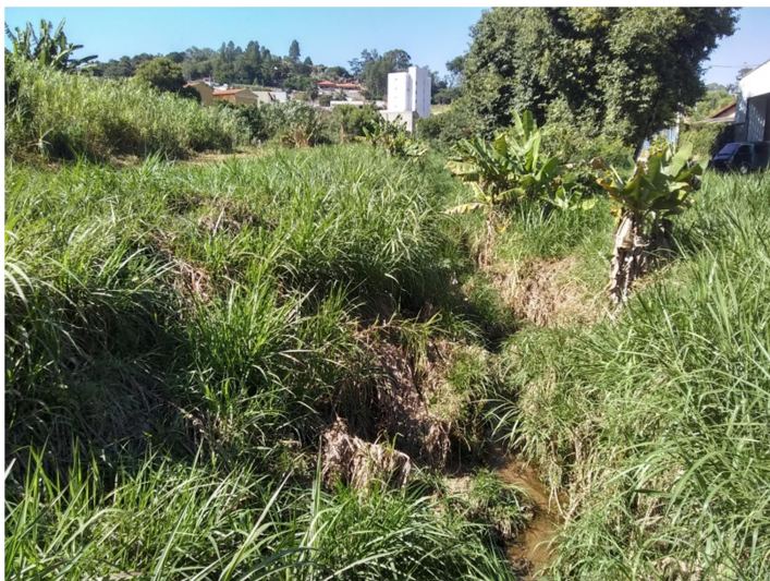
Foto 20: Vista parcial do ponto jusante do trecho.
