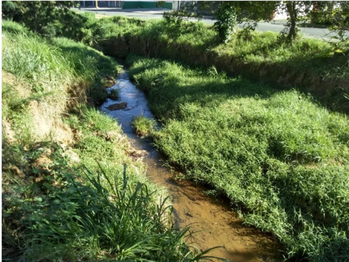
Foto 08: Vista parcial do trecho a ser desassoreado.
