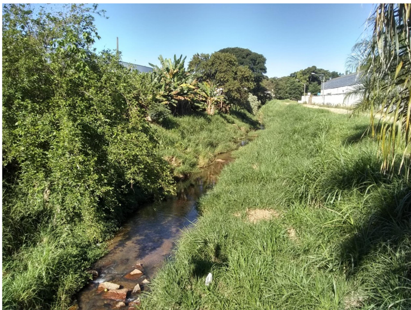
Foto 10: Vista parcial da limpeza e desassoreamento a ser realizado no córrego.
