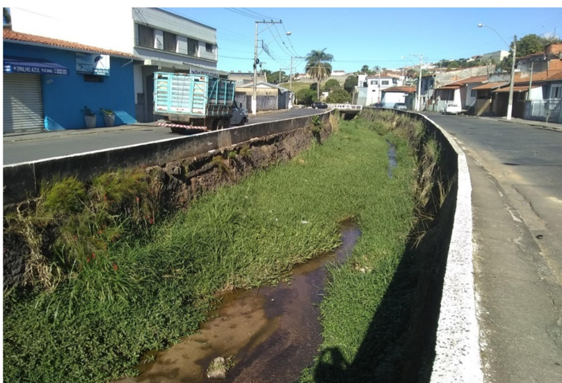
Foto 04: Vista parcial da área a ser desassoreada.
