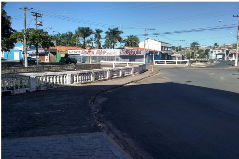
Foto 03: Vista do trecho a montante.
