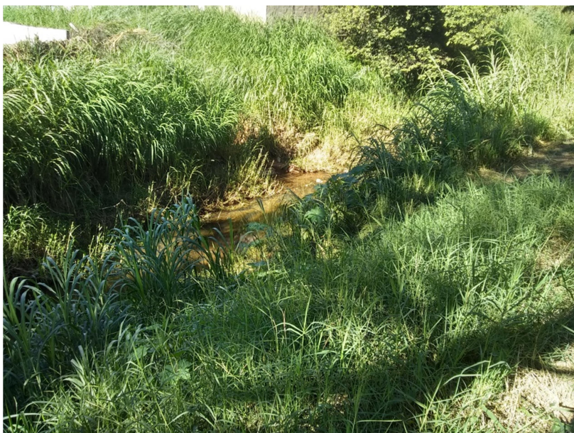
Foto 11: Vista parcial da limpeza e desassoreamento a ser realizado no córrego.
