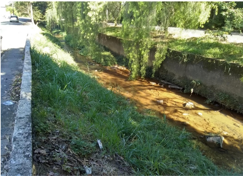
Foto 06: Vista parcial do trecho a ser desassoreado.
