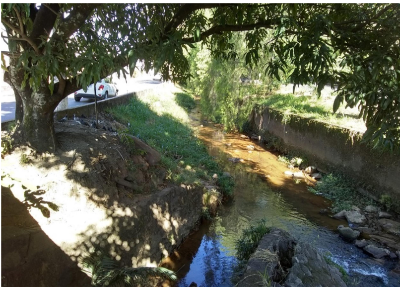
Figura 07: Vista parcial do material a ser retirado da calha.
