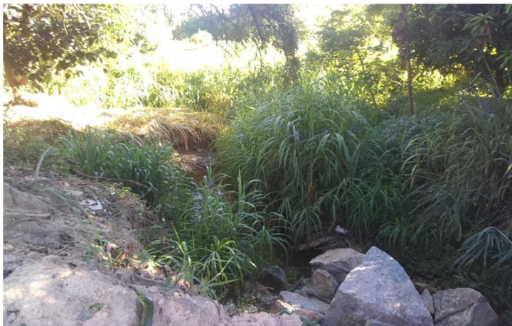
Foto 22: Vista parcial do trecho crítico, limpeza e desassoreamento se fazem necessário.
